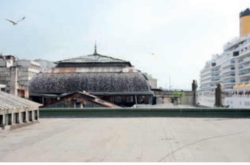
Restorasyon öncesi Paket Postanesi büyük kubbesi
